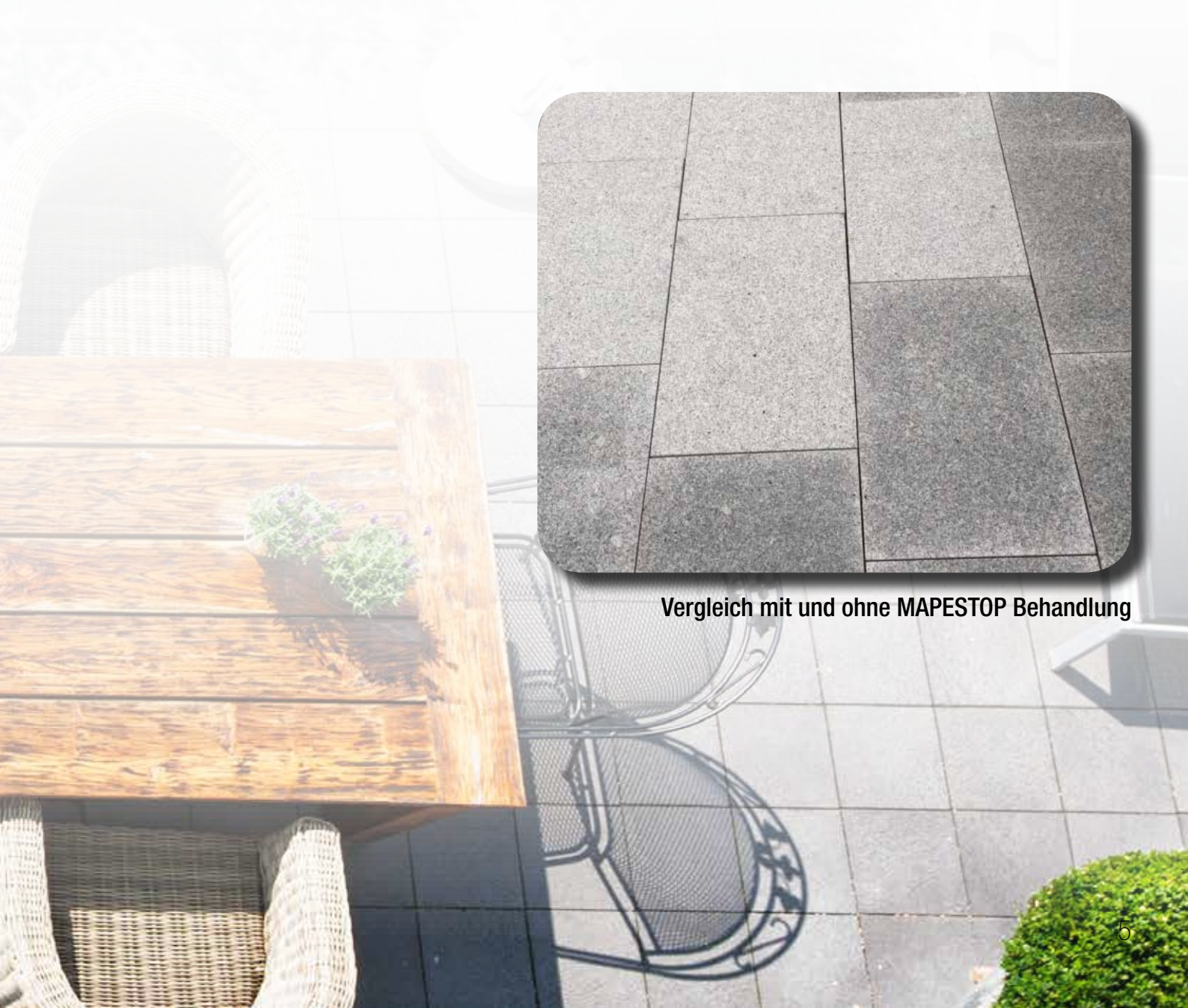
unästhetische Feuchtflecken / Hell-Dunkel-Erscheinung
